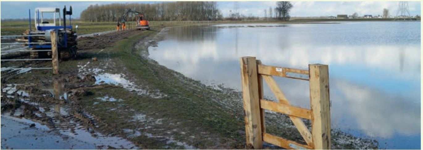
Het toegangshekje naar de Muggenwaard is al geplaatst
