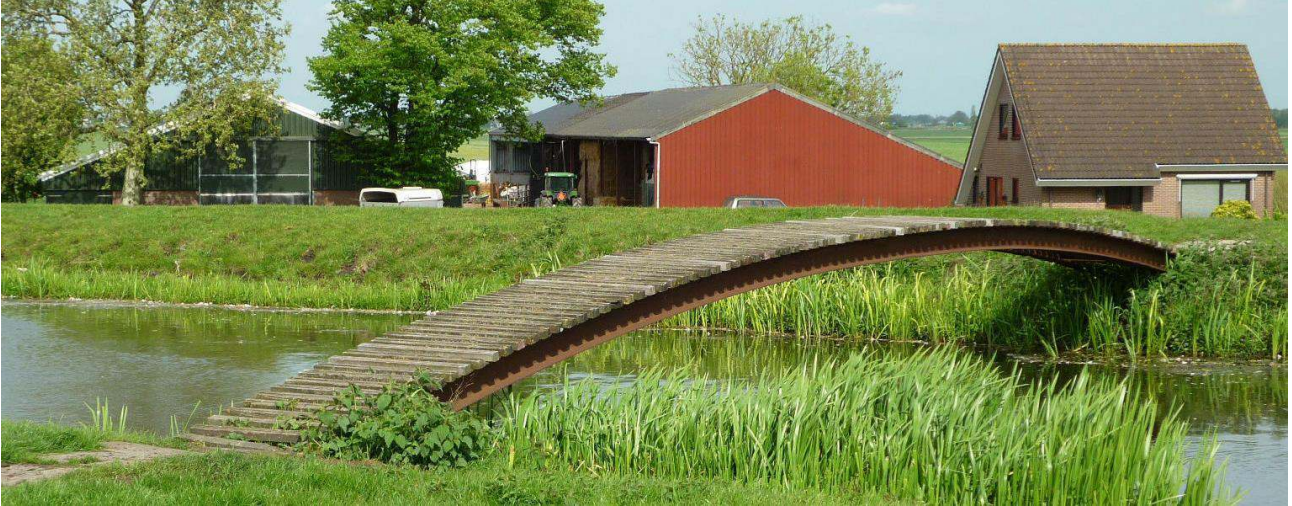
afb. 39 Korteraar, boogbrug 16 m overspanning, stalen liggers, veewering door spleten tussen de dwarsplanken
