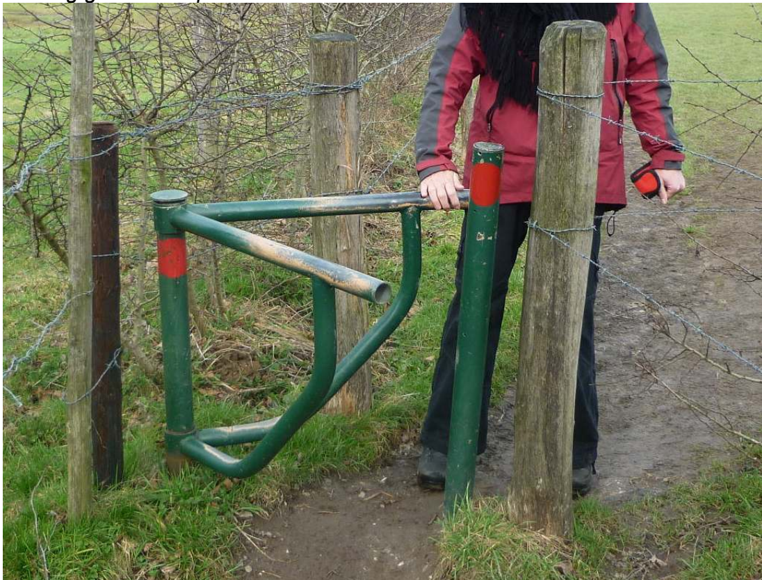
afb. 47 kissing gate/tourniquette
