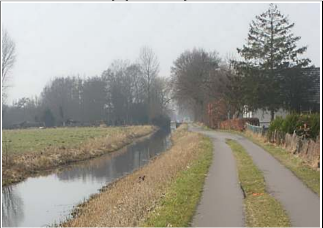
afb. 6 Kromme Rade eind, overgang naar verharding
