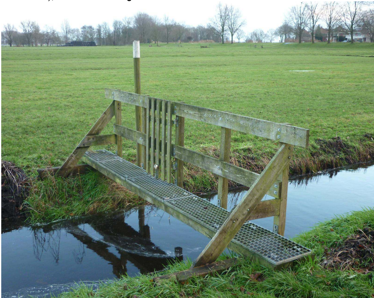
afb. 42 Amsterdam-Amstelland, bruggetje in weilandpad met afsluitbaar klaphek (i.v.m. broedseizoen), veewerende diagonalen en hondenbelemmerende roosters
