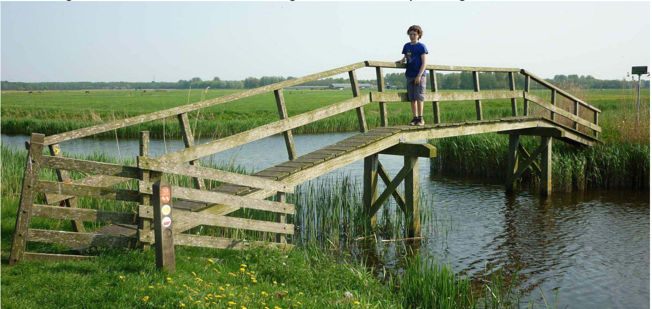
afb. 40 Egmond aan de Hoef, kwakelbrug 12 meter overspanning
