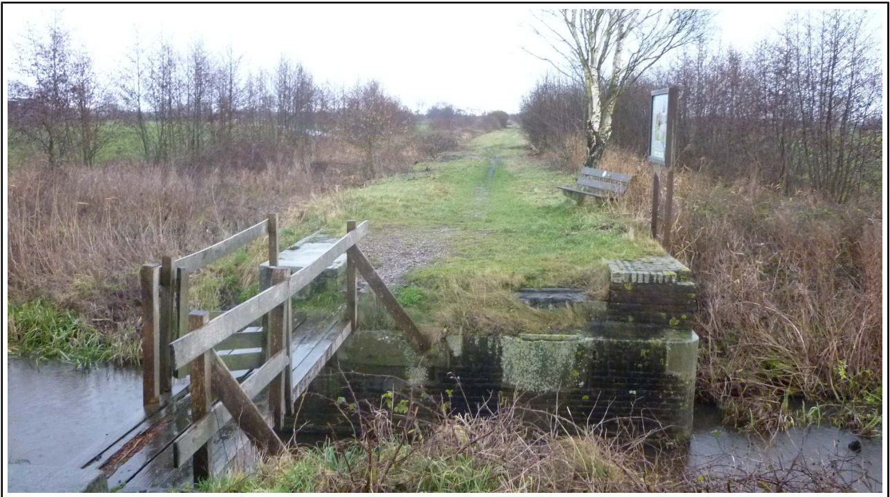
afb. 10 spoordijk niet ver van Demmerikse kade bij Oukooperdijk, brug over Veldwetering (intussen vernieuwd)
