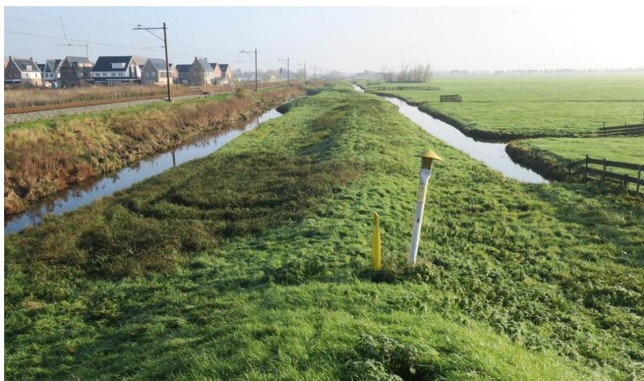
Figuur 7. Zicht op leidingdeel A-515, waar de leiding half-halfligging heeft. Zichtbaar het dijke. Kijkrichting camera naar het oosten (tegengesteld aan richting Figuur 6).
